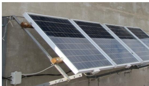
Рисунок 1 – Загальний вигляд сонячних панелей
